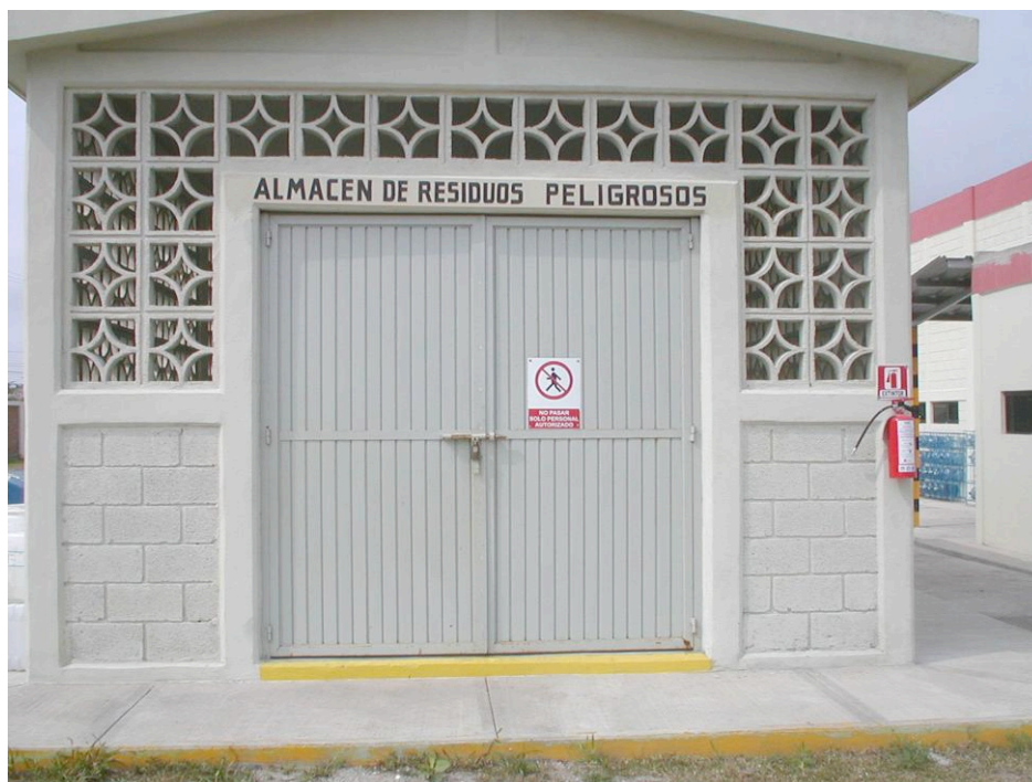
Figura 10. Almacén temporal de residuos peligrosos.
