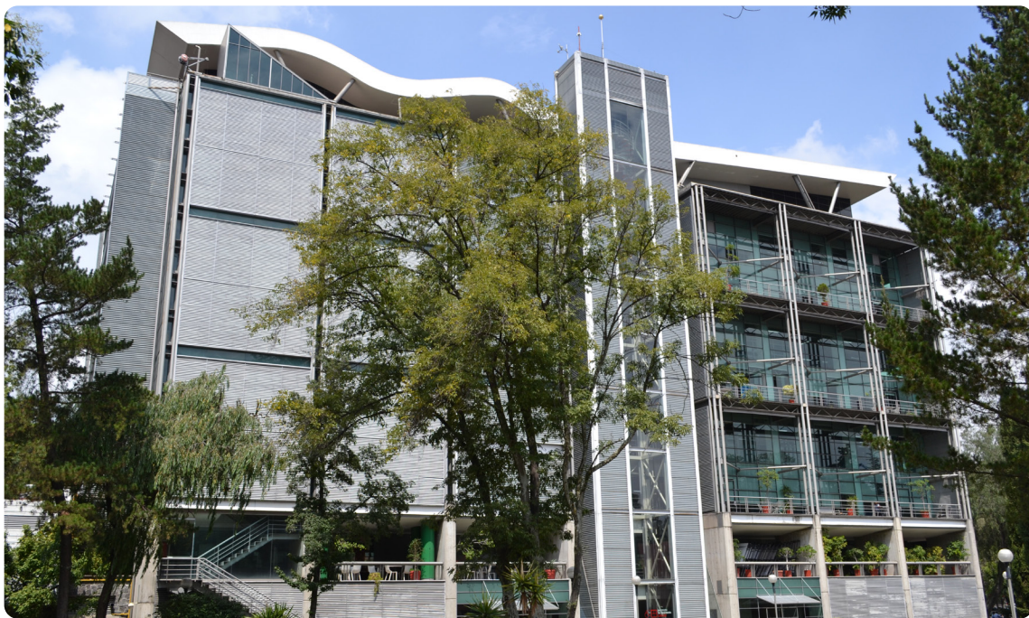
| Torre de Ingeniería
